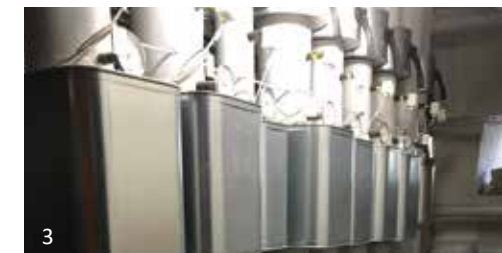
1 // Pufferspeicher Frischwasserstation, Heiligkreuztal 2 // Blockheizkraftwerk, Schönenberg 3 // isolierte Heizungsstränge, Heiligkreuztal
